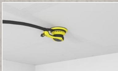
F / Ponçage des joints
