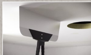
G / Vérification des joints et des panneaux
